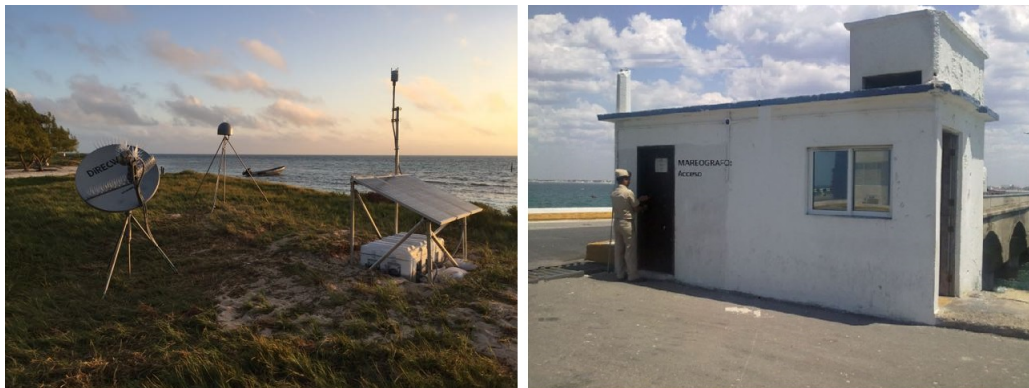
Figura 3.3: Sitio de instalación del GNSS CN26 (izquierda) y del mareógrafo Progreso instalado por el Servicio Mareográfico Nacional (derecha).
