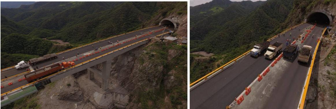
(a) Posicionamiento de los vehículos T3-S3 sobre el doble voladizo para la prueba de carga 1.
