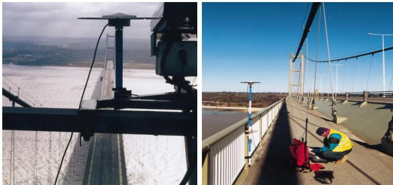
(a) Antena GPS montada sobre el puente. (b) Colocación del receptor GPS.
